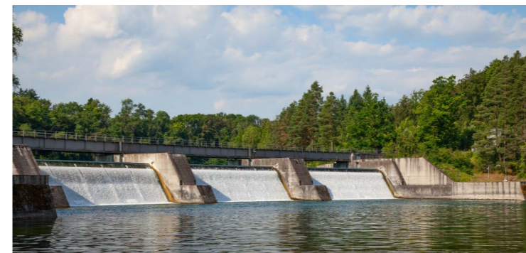
Шульбинская ГЭС, Республика Казахстан. Комплексная поставка распределительных щитов на оборудовании EKF
